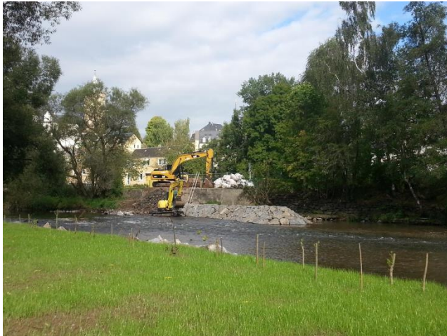
Rückbau Wehr Kreißig
