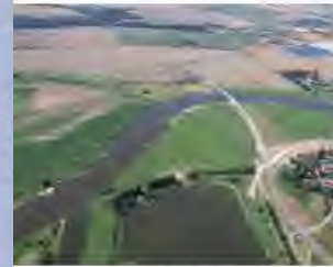
Elbe mit Brücke im Zuge der L 98 zwischen Mühligberg (Brandenburg) und S 182 (Sachsen)
