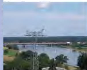
Blick vom Dach des Kraftwerkes Vockerode auf die Elbaue mit der Autobahnbrücke A 8
