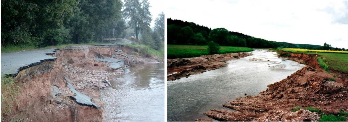
Abb. 32: Ufererosion am Lungwitzbach durch das Hochwasser 2002 (Fotos: LTV)
