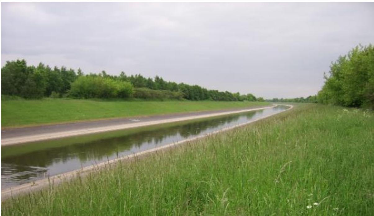
*Abb. 5: Beispiel für den Totalverlust von natürlichen Überschwemmungsflächen an einem Abschnitt der Weißen Elster, der aufgrund des Tagebaus Zwenkau vollständig aus der natürlichen Aue heraus in ein Betonbett verlegt wurde (Foto: LfULG, Strukturkartierung)*
