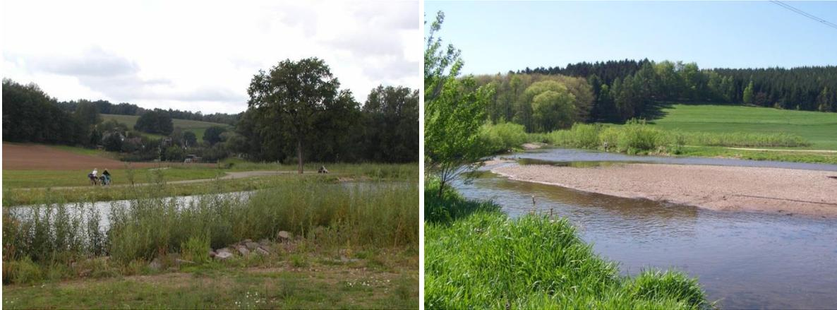
*Abb. 34: Radweg mit Verweilmöglichkeit am Lungwitzbach und Erlebbarkeit im Bereich der Aufweitung, die als Sedimentfang dient (Fotos: A. Stowasser)*
