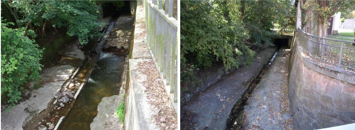
*Abb. 37: Schaden in der Sohlbefestigung des Mortelbachs durch das Hochwasser 2013 (links) und Sanierung des Schadens durch Wiederherstellung des Ausbauzustands (rechts) (Fotos: LfULG)*
