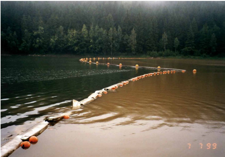
Abbildung 16: Trübung nach einem Starkregen mit Bodenerosion, Tauchwand im Zulauf Haselbach der Talsperre Saidenbach zur Vergleichmäßigung und Erhöhung der Sedimentation
