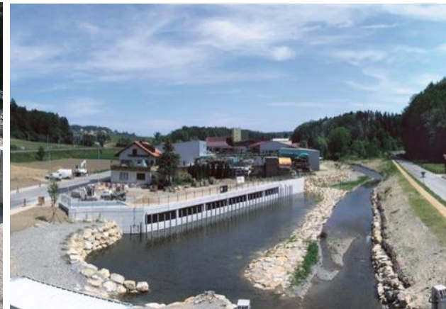
Entlastungsstollen Lyssbach, Lyss BE
